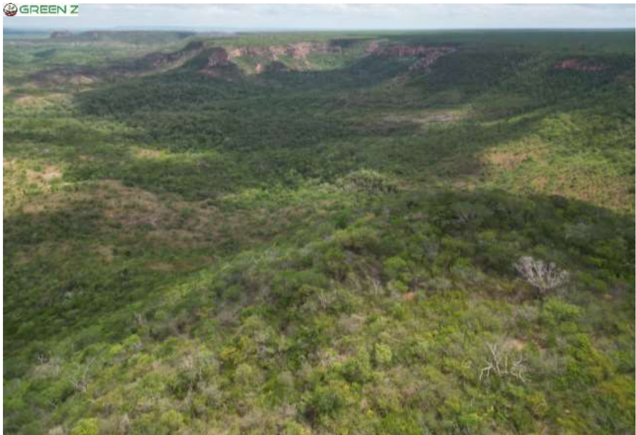
Figura 38. Representação da integração entre as áreas de proteção (RL e APP) da Fazenda Vereda da Lagoa. (Coordenadas Geográficas da posição de sobrevoo da referida área com drone: -7,8957 S; -43,6214 O. Data da imagem: 24/11/2023).
