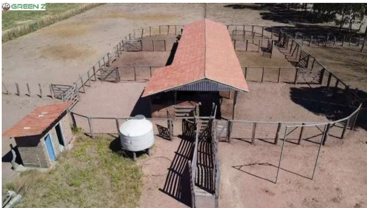
Figura 10. Estrutura para apoio (curral) ao manejo operacional e fitossanitário do gado bovino criado na Fazenda Vereda da Lagoa. (Coordenadas Geográficas da posição de sobrevoo da referida área com drone: -07,5418 S; -43,3525 O. Data da imagem: 15/11/2023).
