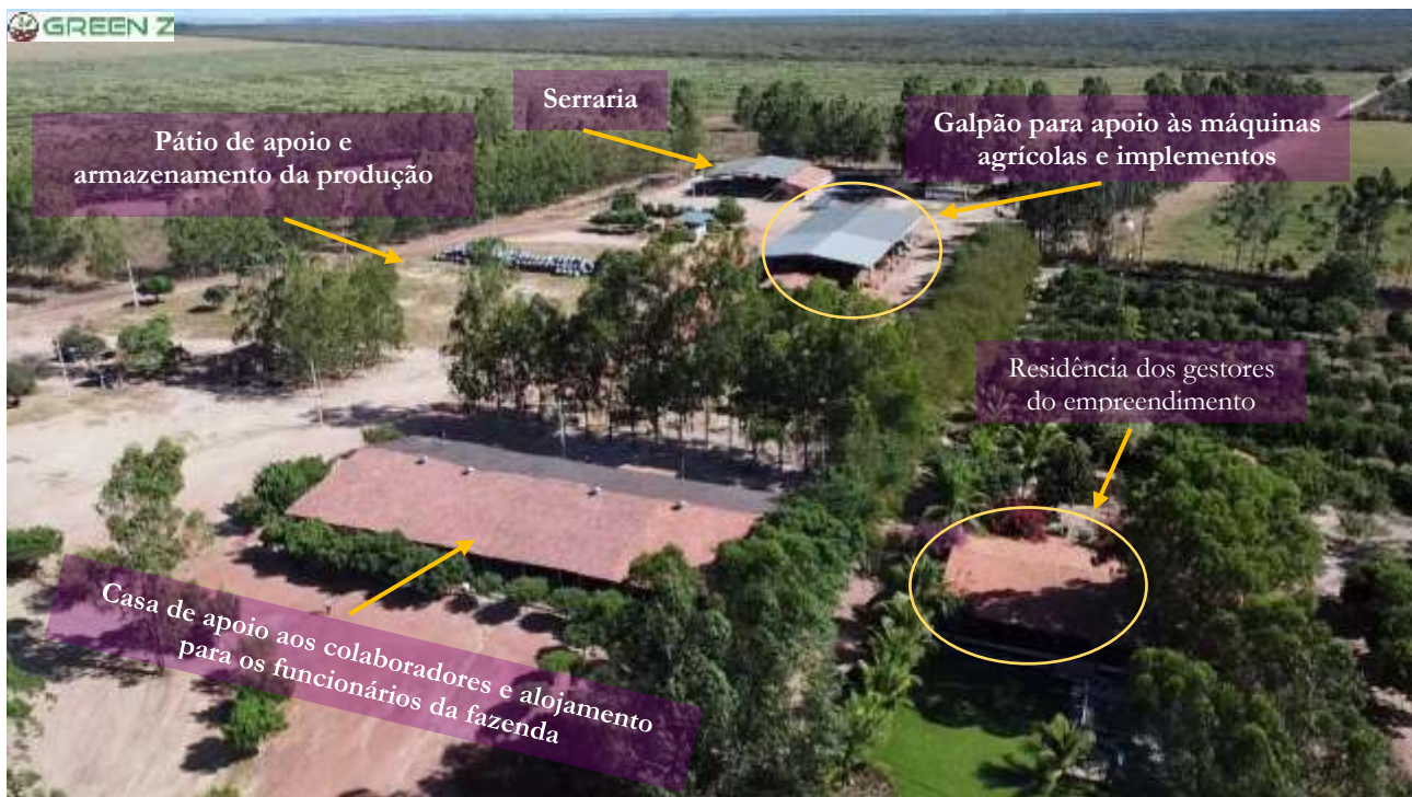
Figura 2. Infraestrutura básica da Fazenda Vereda da Lagoa. (Coordenadas Geográficas da posição de sobrevoo da referida área com drone:-7,9046 S; -43,5571 O. Data da imagem: 15/11/2023).
