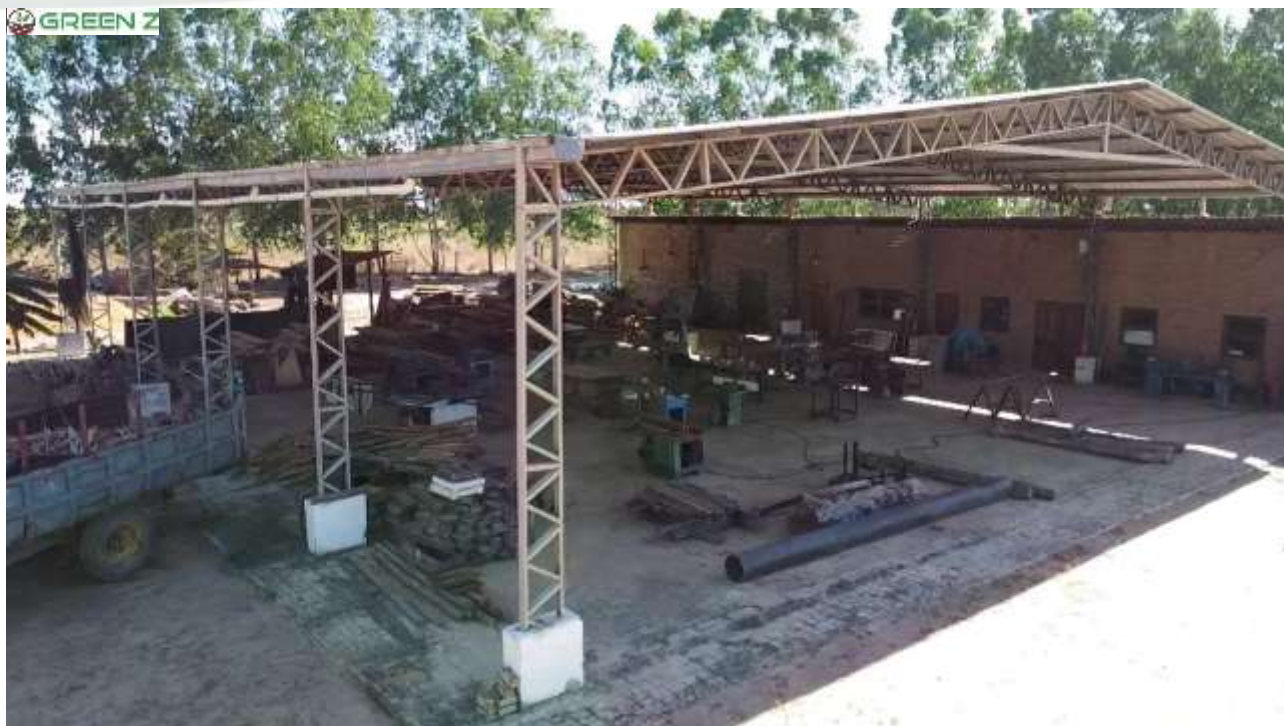
Figura 7. Serraria existente na área da Fazenda Vereda da Lagoa cuja operação é licenciada pelos órgãos ambientais pertinentes. (Coordenadas Geográficas da posição de sobrevoio da referida área com drone: - 07,5351 S; -43,3338 O. Data da imagem: 15/11/2023).
