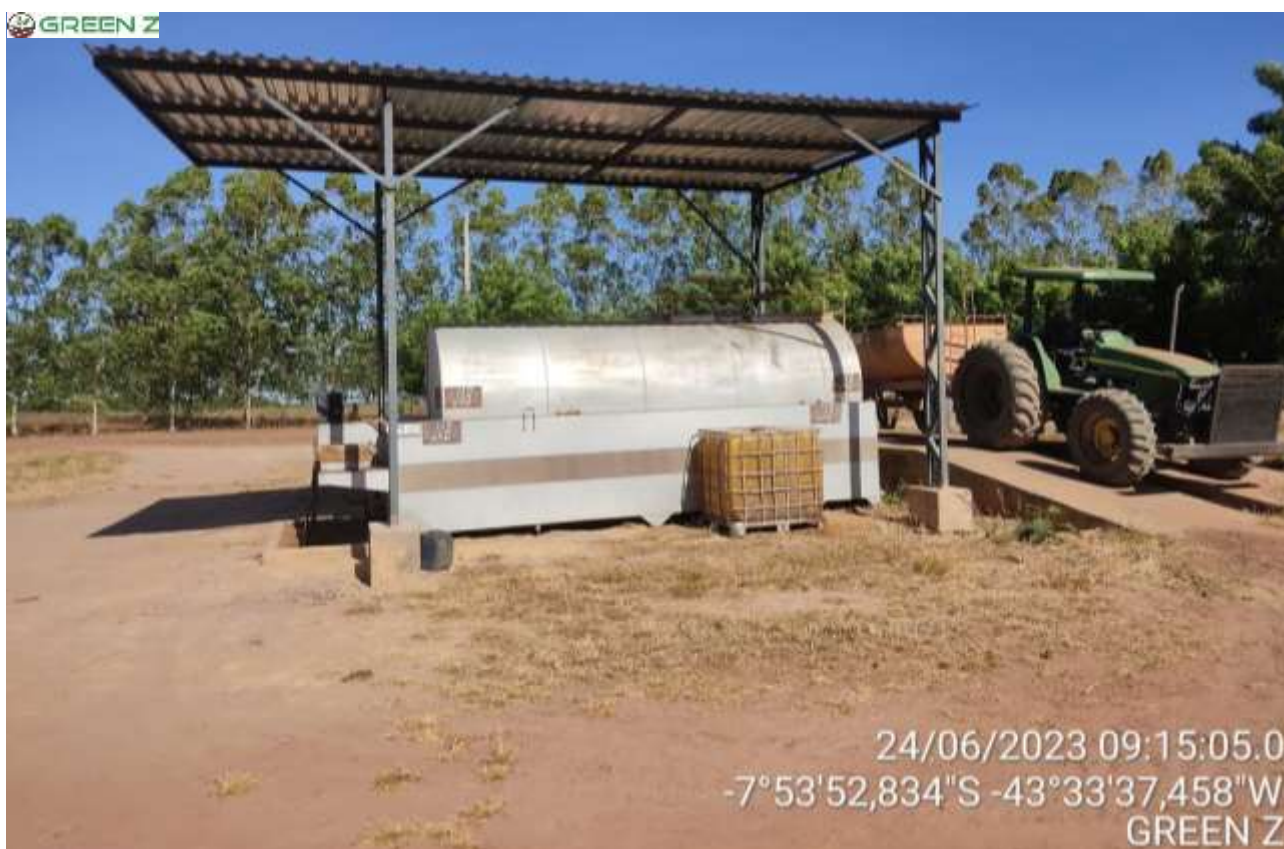
Figura 8. Estrutura de apoio e tanque de armazenamento de combustível utilizado para abastecimento dos veículos e máquinas utilizados nas operações da Fazenda Vereda da Lagoa.
