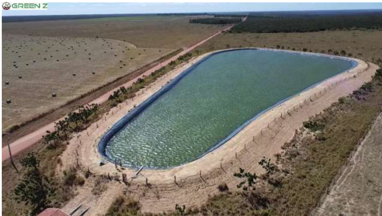
Figura 18. Tanque de armazenamento da água utilizada no pivô central.
