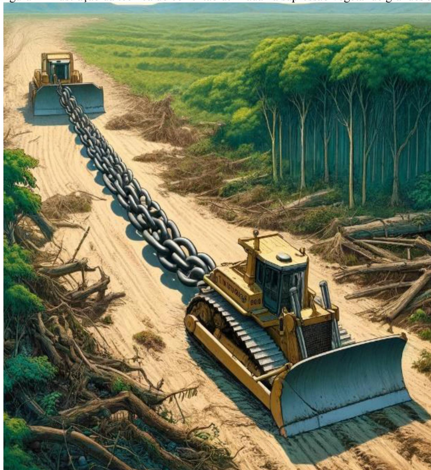
Figura 9 - Ilustração da técnica do correntão utilizada na supressão vegetal de grandes áreas.
