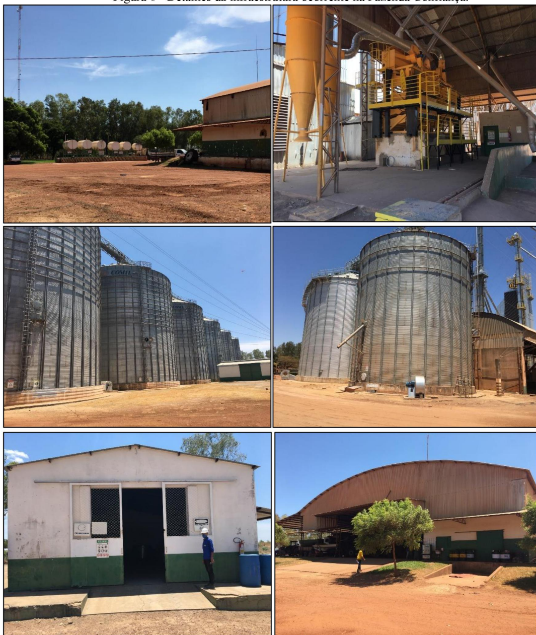
Figura 6 - Detalhes da infraestrutura ocorrente na Fazenda Confiança.
