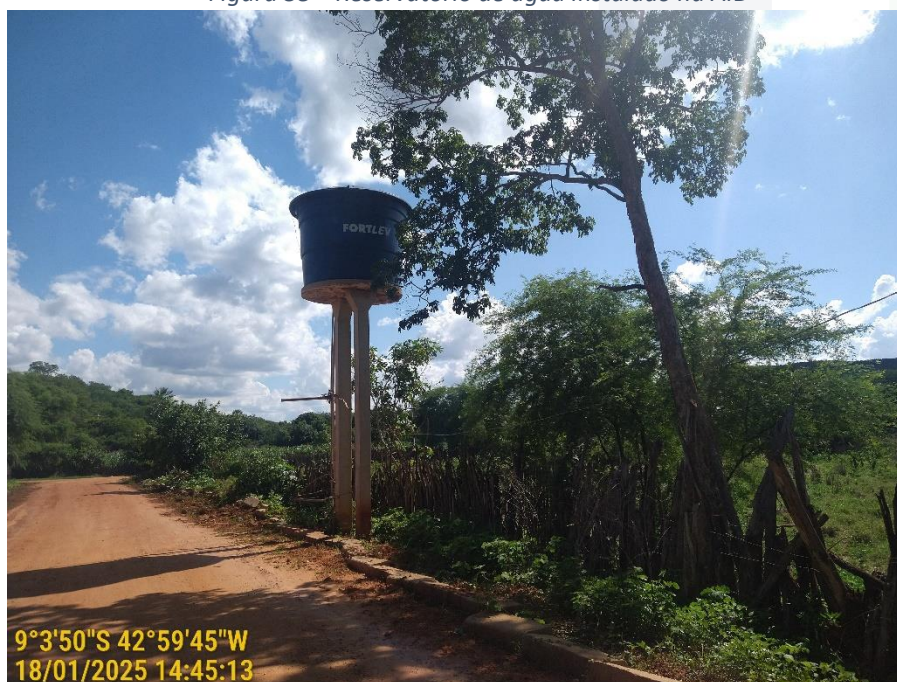
Figura 38 – Reservatório de água instalado na AID
