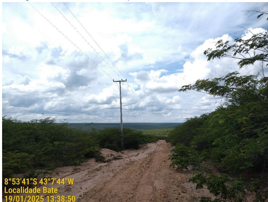
Figura 37 – Linha de transmissão paralela à via de acesso à ADA, em território de AID
