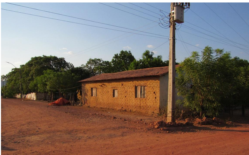
Figura 108. Domicílio com paredes de adobe, paredes parcialmente revestidas com cimento e coberto com telha no povoado Pratinha em Uruçuí – PI.
