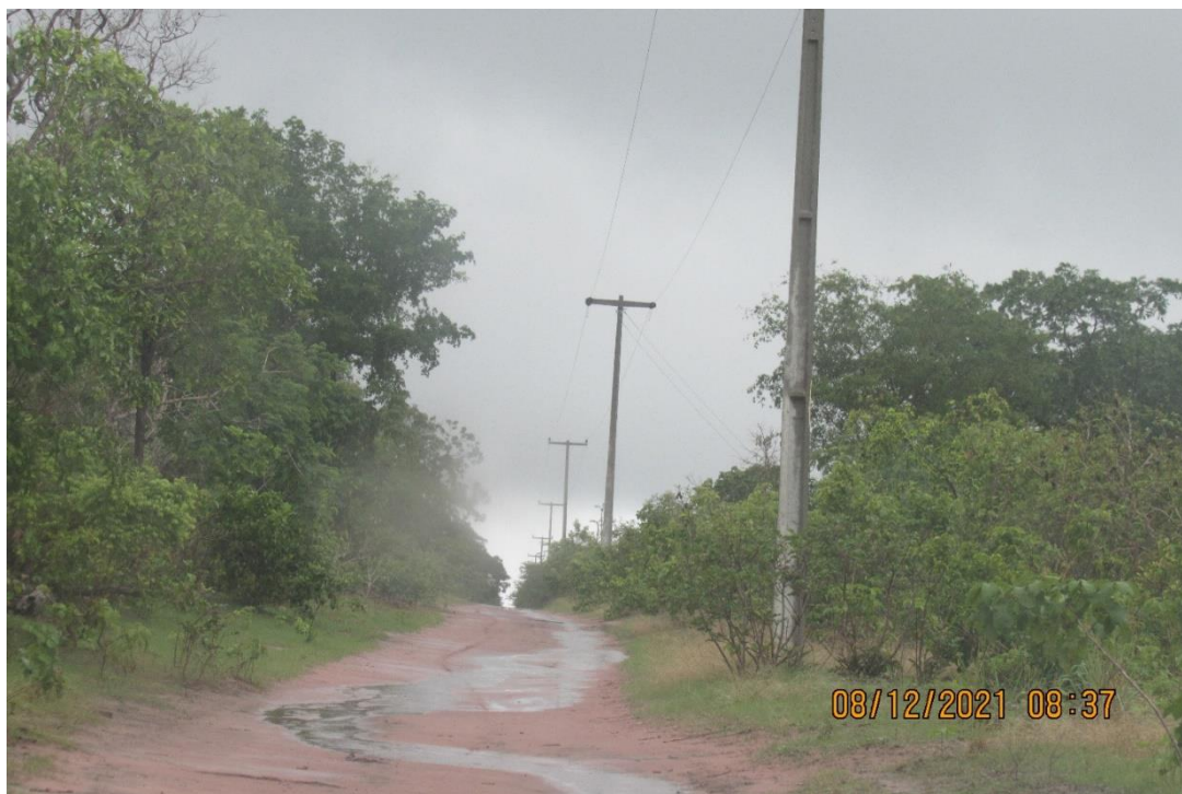
Figura 119. Estrada vicinal de acesso à área de abrangência da Fazenda Jerusa em Canavieira - PI.
