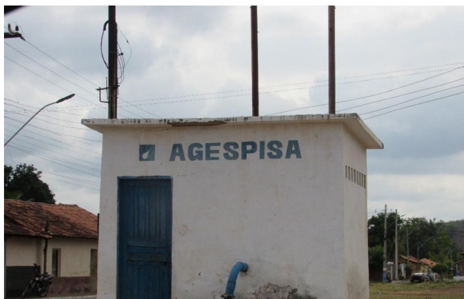
Figura 94. Central de distribuição de água pela Agespisa S/A.
