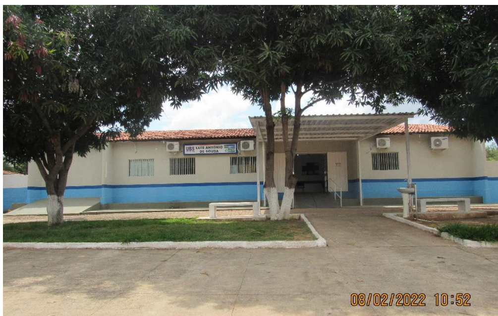
Figura 100. Unidade Básica de Saúde Luís Antônio de Sousa na sede do município de Sebastião Leal – PI.
