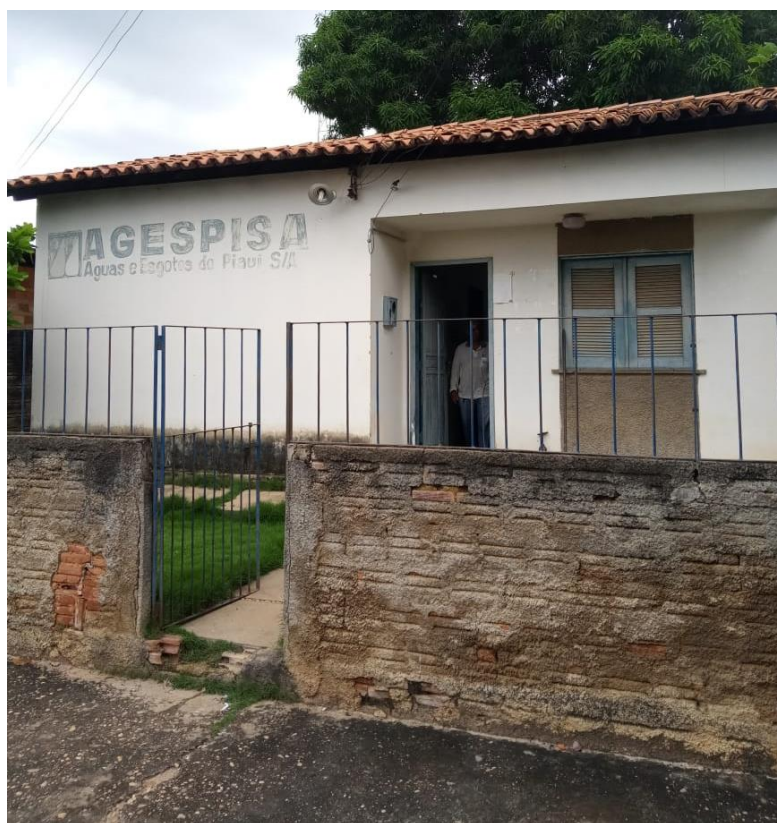
Figura 120. Escritório da Empresa Águas e Esgoto do Piauí S/A – AGESPISA.
