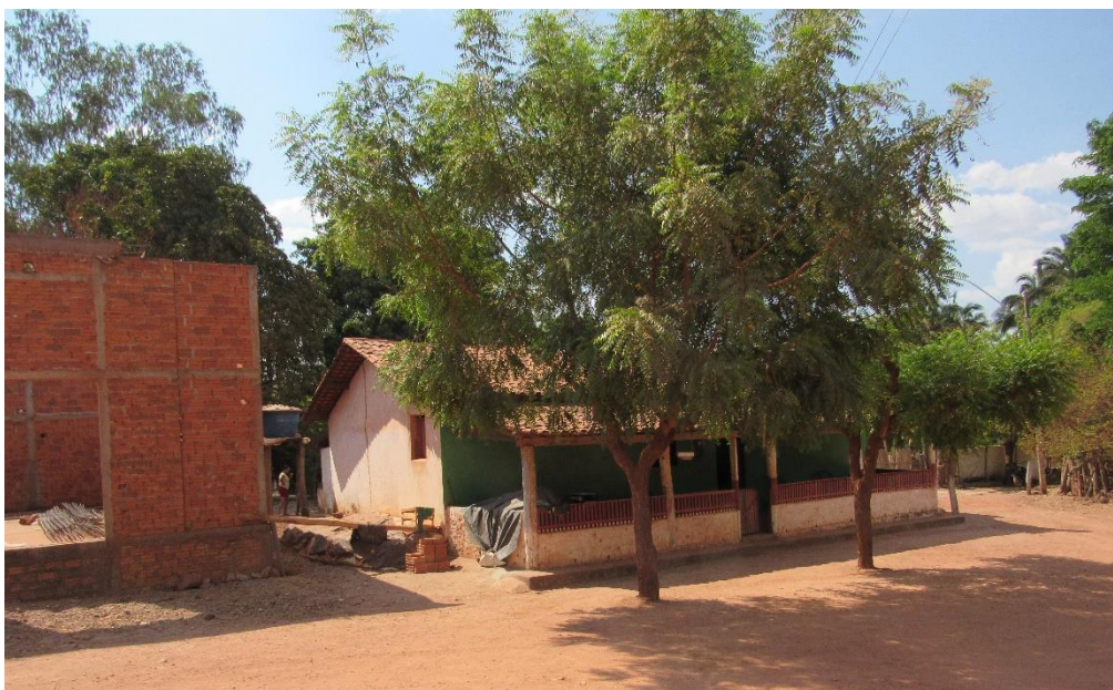
Figura 107. Domicílio com paredes revestidas com reboco no povoado Pratinha em Uruçuí – PI.
