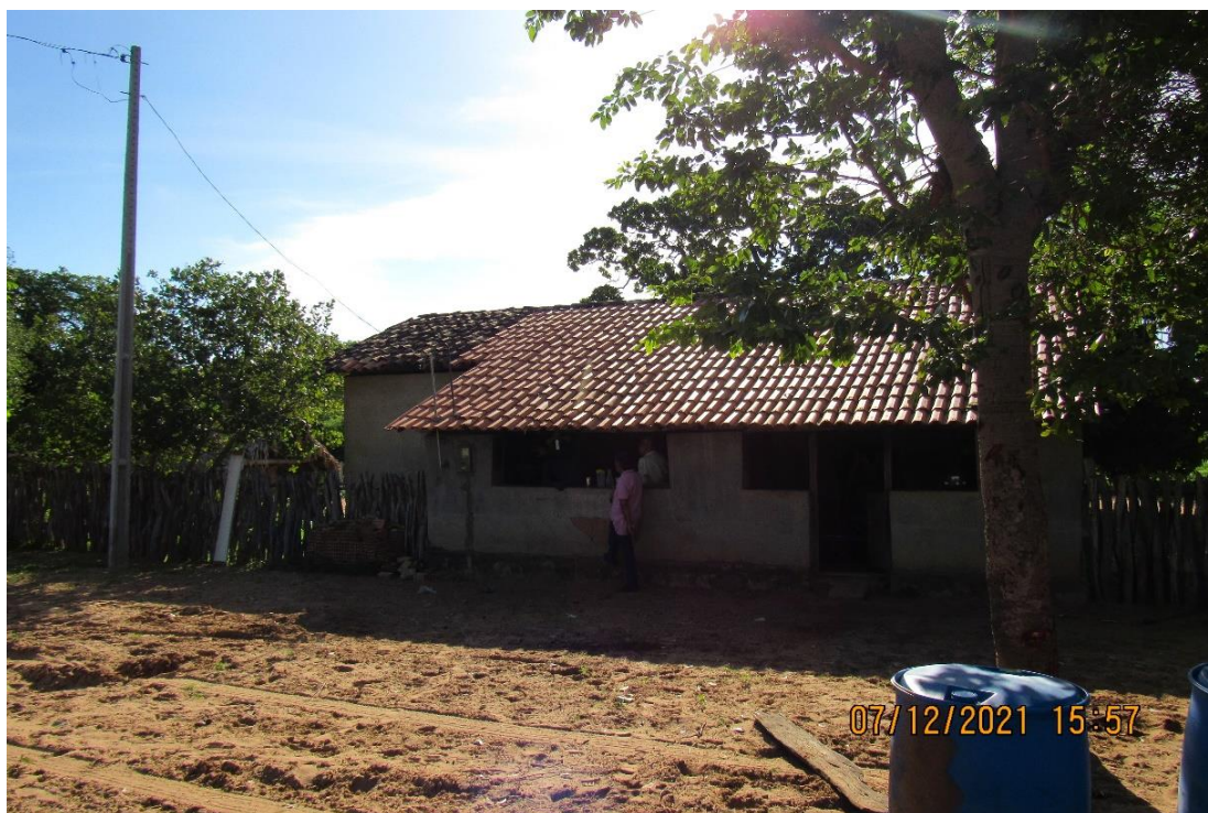
Figura 118. Imóvel com revestimento em reboco parcial na área de abrangência da Fazenda Jerusa em Canavieira – PI.
