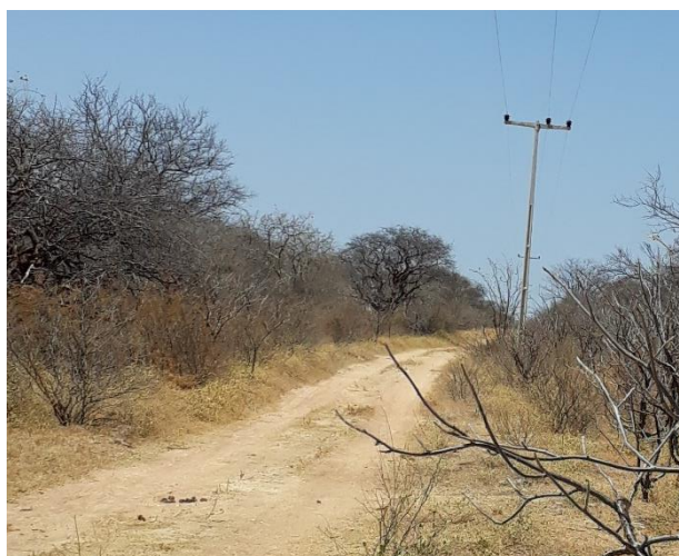
Figura 04 – Estrada vicinal de acesso à área de lavra
