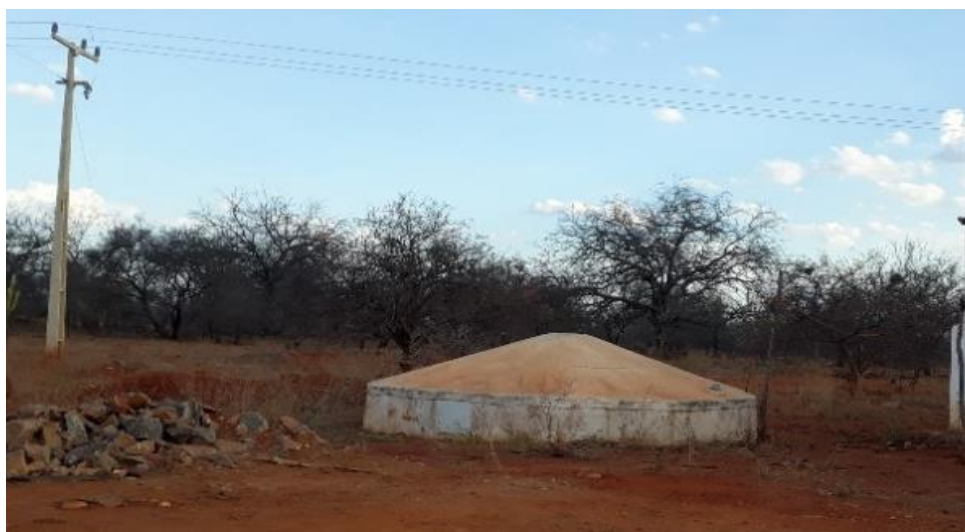
Figura 8 – Cisterna de armazenamento de água construída no Povoado Angical
