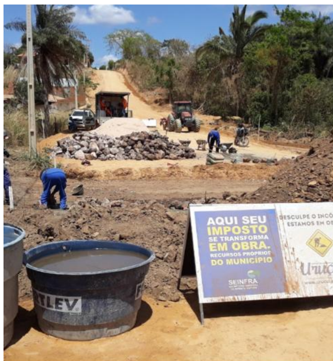
Figura 53. Obra de saneamento básico no município de Uruçuí. Fonte: Prefeitura municipal.
