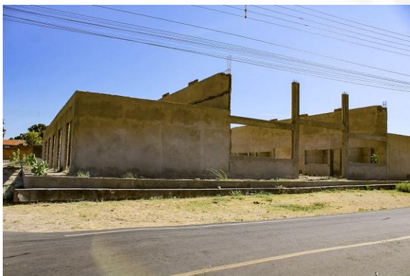
Rodoviária em construção em Jerumenha, PI.
