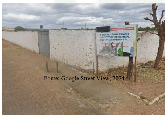
Figura 49. Vista do Estádio de Futebol em construção em Marcos Parente - PI pelo Google Street View
