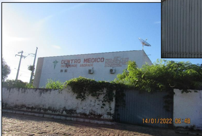
Hospital Municipal em Itaueira
