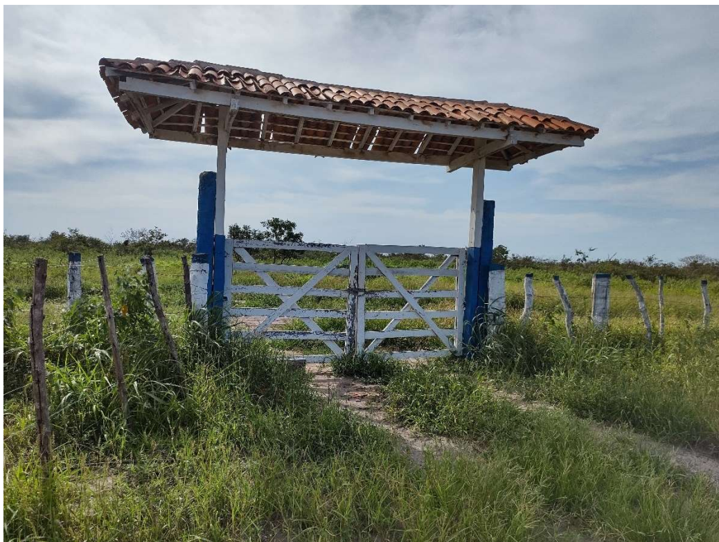
Portão de acesso aos imóveis Nossa Senhora das Graças 4 e 5
