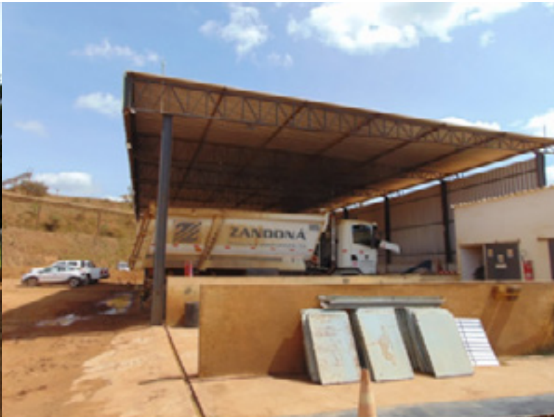
▶ Oficina, lubrificação e lavagem de veículos da Unidade de Mineração de Angico dos Dias – UMA.
