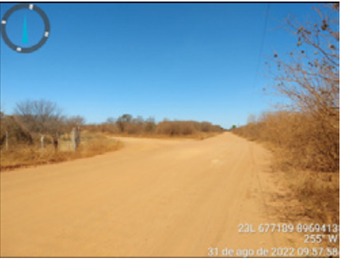
◀ Ponto de controle de tráfego CT1, localizado na Rodovia PI-144.
