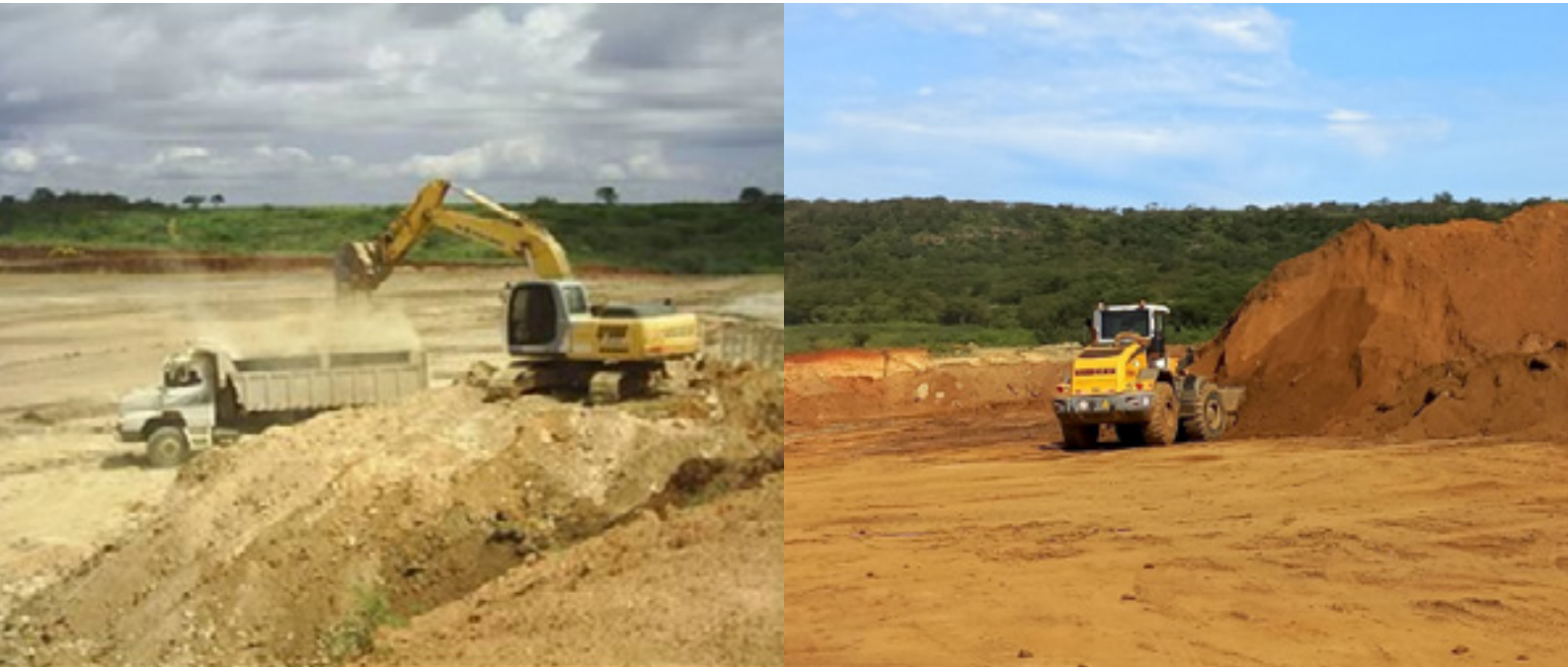
▲ Remoção do minério de fosfato na área da UMA, através de uso de escavadeira sobre esteiras, semelhante ao que deve ocorrer na Fazenda Pimenteiras, na poligonal do processo ANM 800.218/1985.
