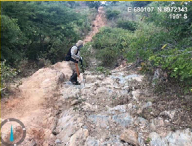
▲ Estrada abandonada no limite leste da área de estudo. A declividade acentuada e o fluxo de água pluvial turbulento provocaram o aparecimento de diversas feições erosivas no local, sobretudo sulcos e ravinas de diversas dimensões.
