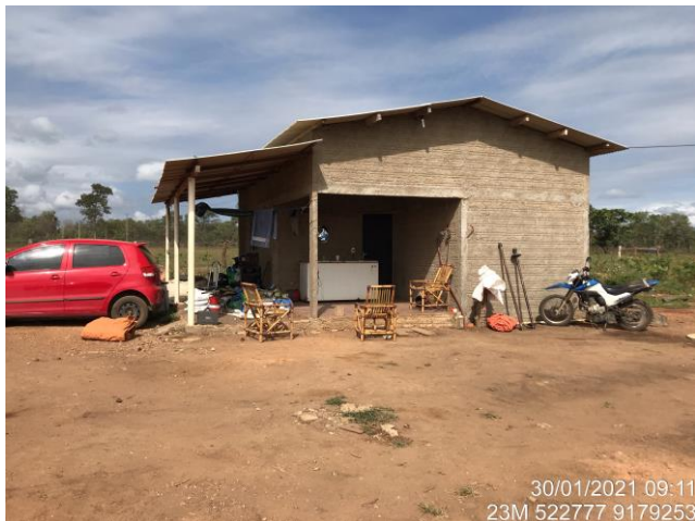
Foto 1: Residência de apoio.
