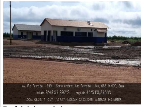
Refeitório e alojamento
