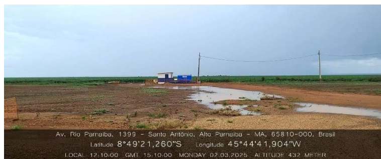
Imagem 11: Usina Elétrica de Combustão a diesel e gerador de 220v
