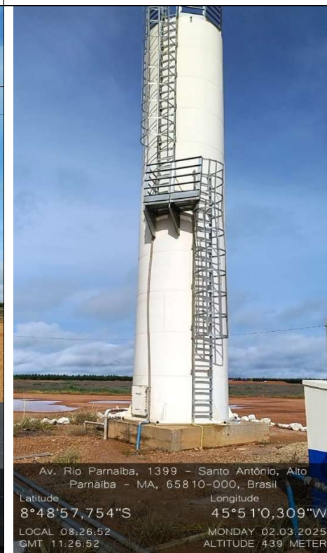
Caixa d'água com capacidade para 50.000litros
