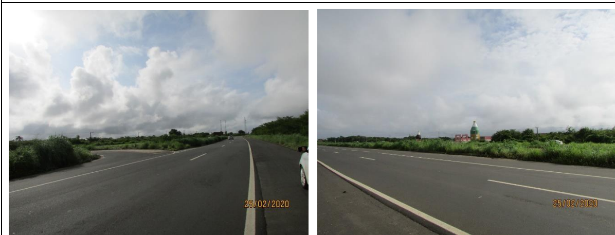
Foto 1 e Foto 2: Início do trecho a ser duplicado—Coordenadas: 5°12'55.1"S e 42°45'12.9"O
