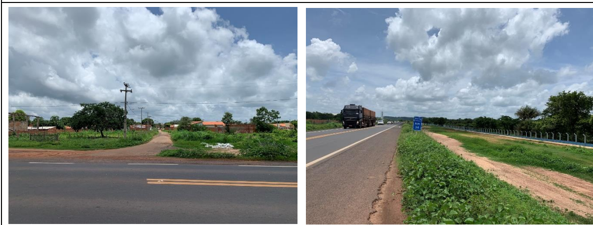
Foto 3 e Foto 4: Final do trecho a ser melhorado – Coordenadas: 5°22'12.1"S e 42°40'20.5"O
