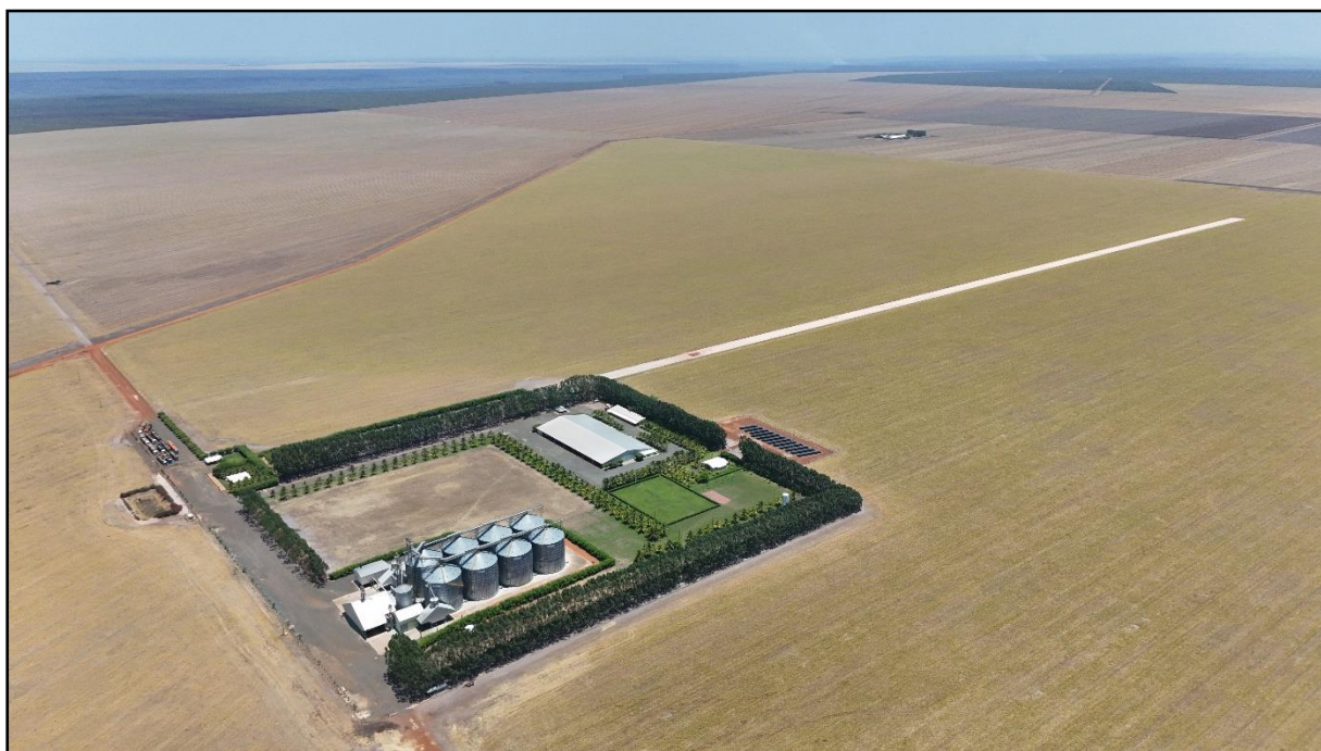
Figura 2.2 – Foto aérea da infraestrutura da sede do Bloco Fazenda Imperial, Sebastião Leal-PI.
