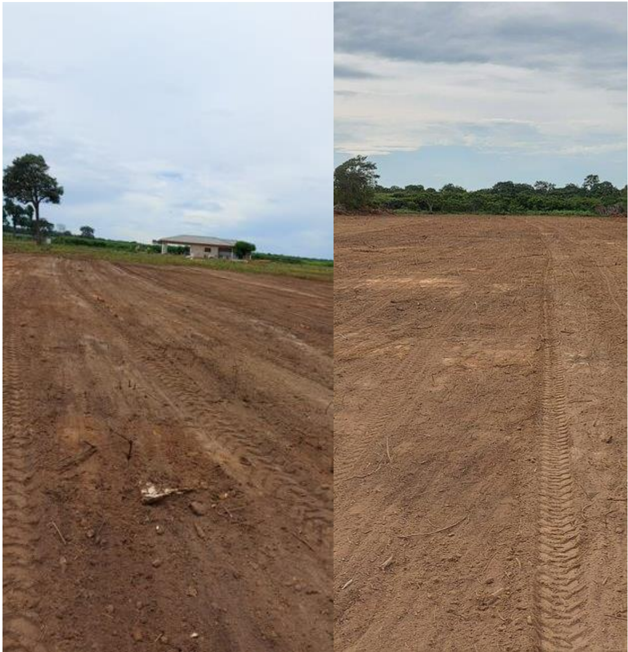
Figura 47 – Anexo. Área da pista de avião, em construção.
