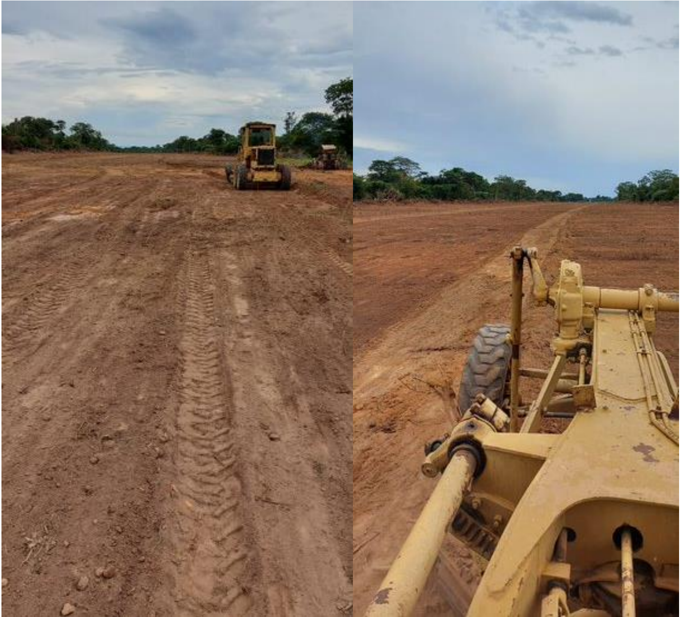
Figura 46 – Anexo. Área da pista de avião, em construção.
