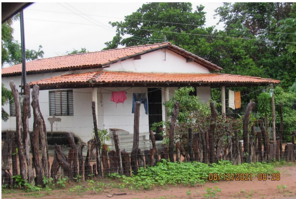
Figura 111. Imóvel com paredes revestidas com reboco total na área de abrangência da Fazenda Jerusa em Canavieira – PI.
