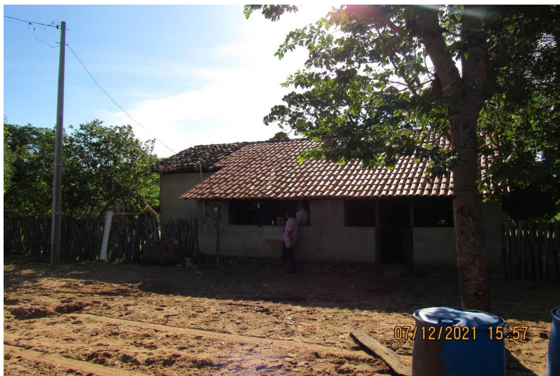
Figura 113. Imóvel com revestimento em reboco parcial na área de abrangência da Fazenda Jerusa em Canavieira – PI.
