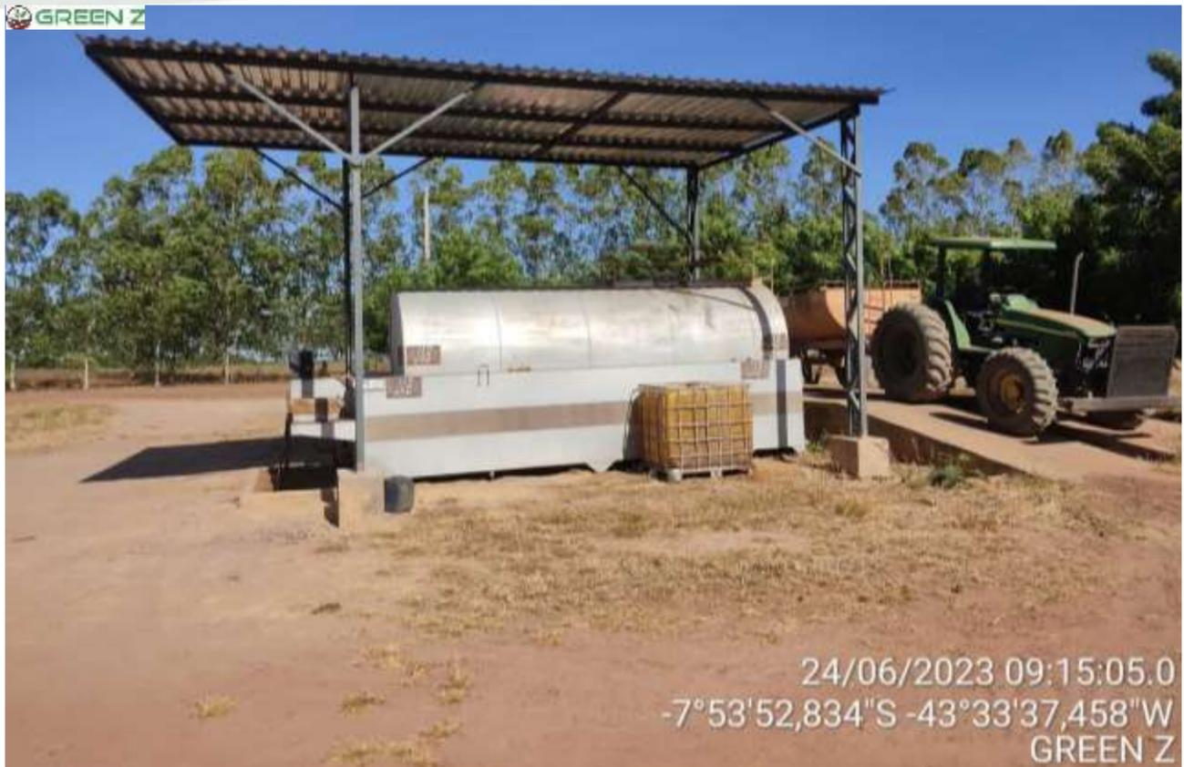
**Figura 19.** Estrutura de apoio e tanque de armazenamento de combustível utilizado para abastecimento dos veículos e máquinas utilizados nas operações da Fazenda Vereda da Lagoa.
