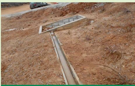
Exemplo de medida do PAC: Controle de Erosão e Assoreamento - implantação de rede de drenagem em talude, visando à coleta e escoamento das águas pluviais
