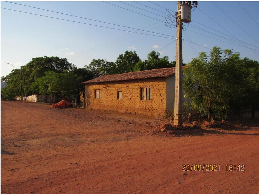
Figura 81. Domicílio com paredes de adobe, paredes parcialmente revestidas com cimento e coberto com telha no povoado Pratinha em Uruçuí – PI.
