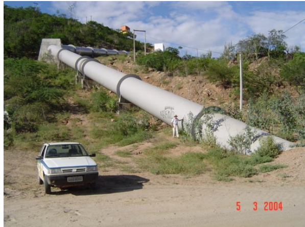
Foto 5-4 - Adutora elevatória montada sobre pilotis.
