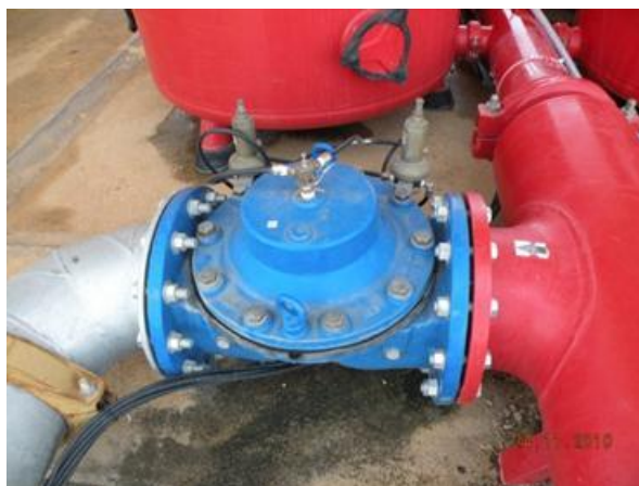
Foto 5-12 - Válvula reguladora de pressão.
