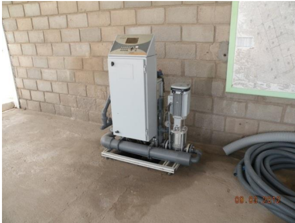
Foto 5-15- Sistema de injeção de soluções nutritivas e afins.
