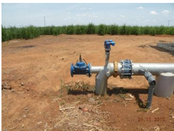
Foto 5-13 - Equipamentos de segurança (retenção, ventosas e alívio).
