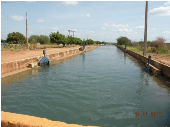
Foto 5-5 - Canal principal revestido em concreto com comportas para canais secundários.
