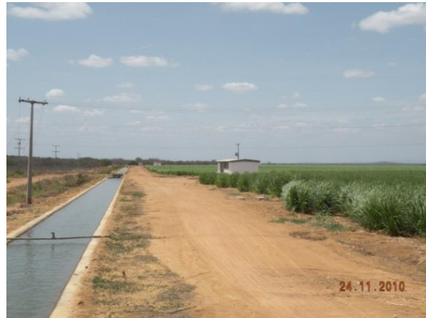
Foto 5-6 - Canal secundário alimentando unidade de bombeamento on farm.
