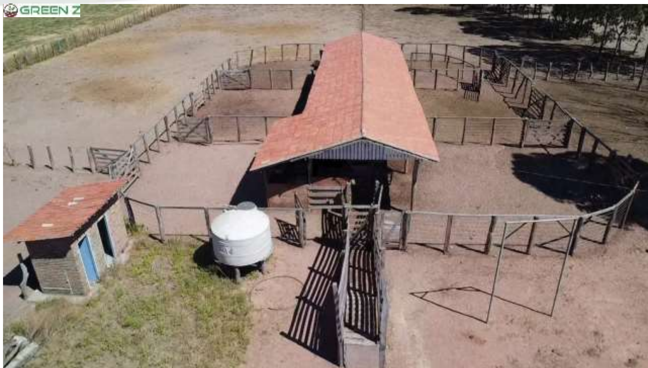
Figura 21. Estrutura para apoio (curral) ao manejo operacional e fitossanitário do gado bovino criado na Fazenda Vereda da Lagoa. (Coordenadas Geográficas da posição de sobrevoo da referida área com drone: -07,5418 S; -43,3525 O. Data da imagem: 15/11/2023).
