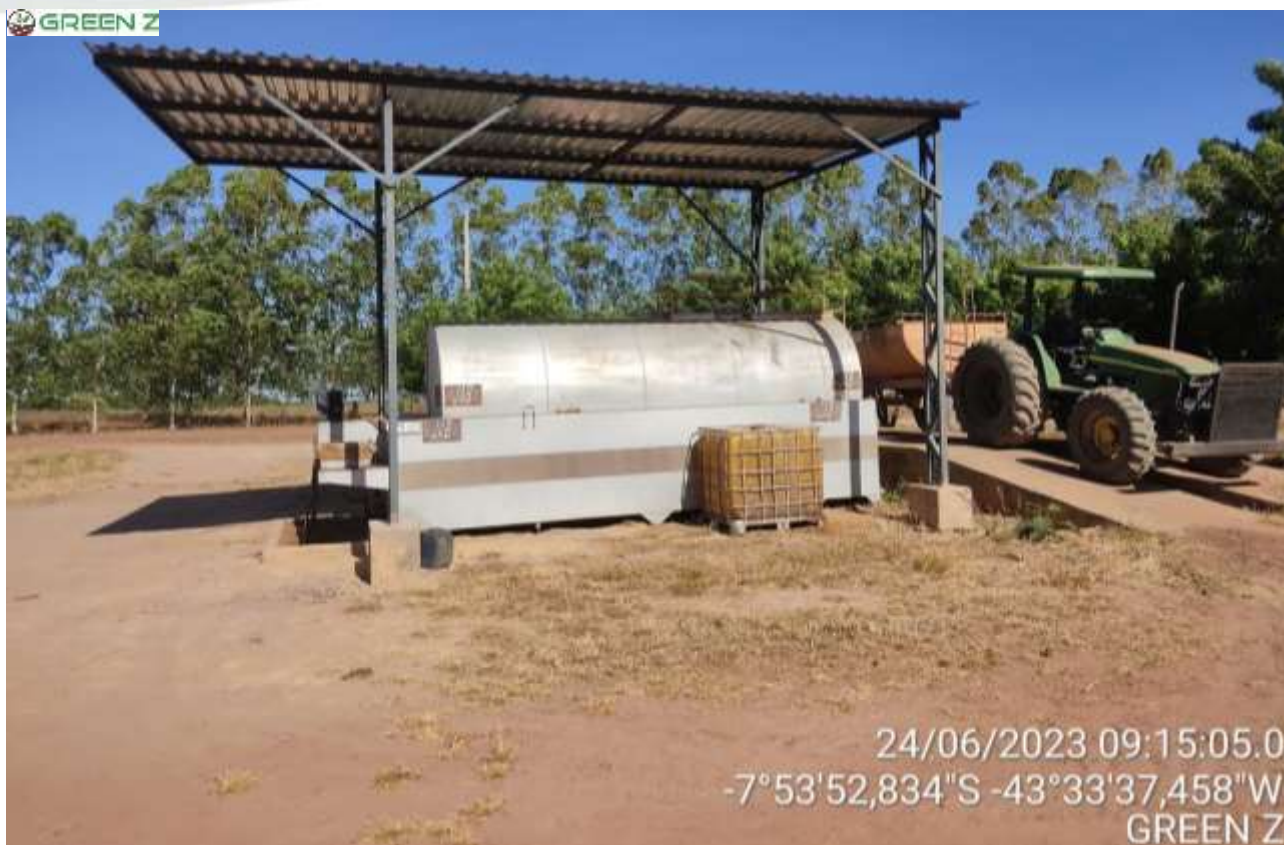
Figura 19. Estrutura de apoio e tanque de armazenamento de combustível utilizado para abastecimento dos veículos e máquinas utilizados nas operações da Fazenda Vereda da Lagoa.
