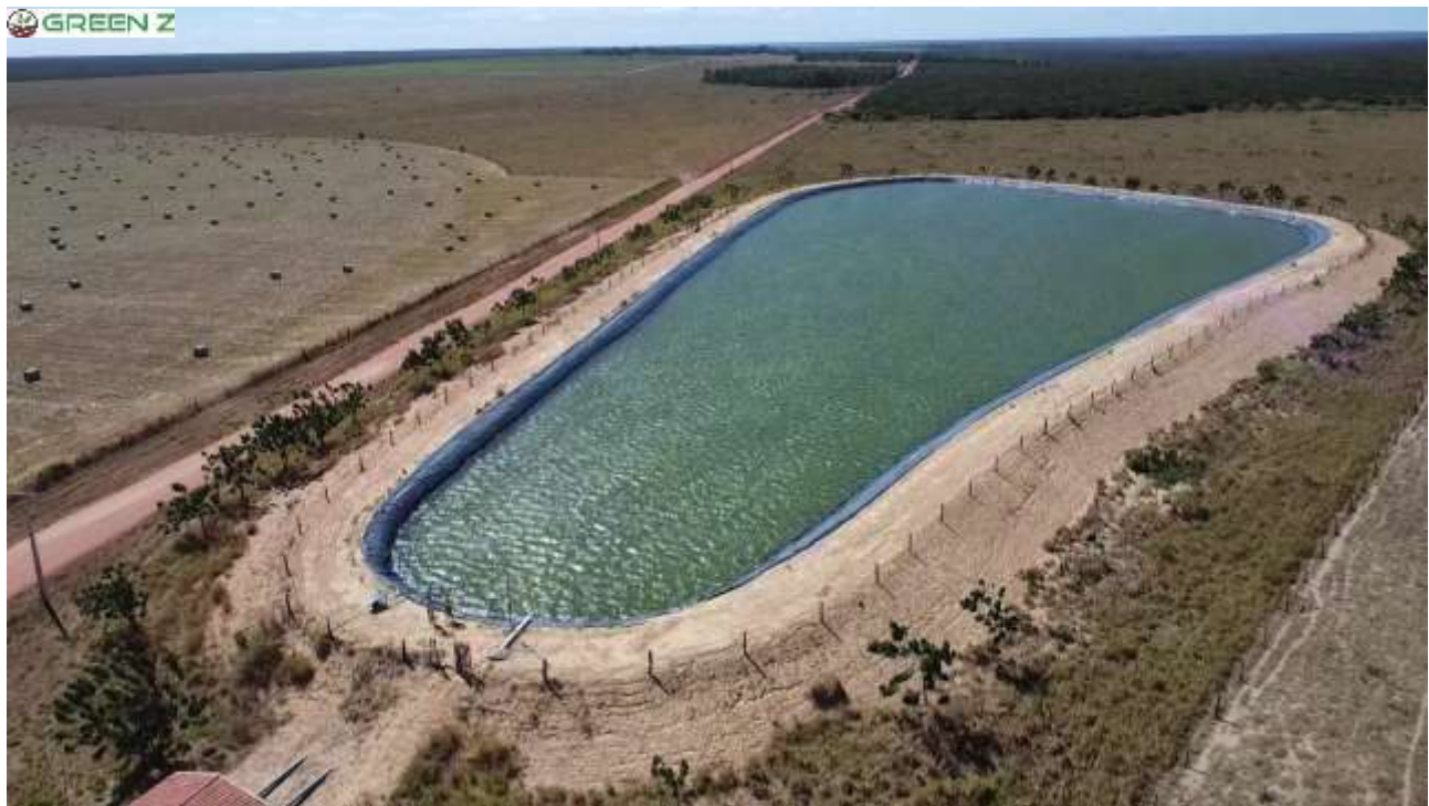
Figura 8. Tanque de armazenamento da água utilizada no pivô central.
