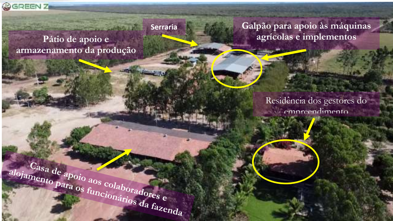
Figura 13. Infraestrutura básica da Fazenda Vereda da Lagoa. (Coordenadas Geográficas da posição de sobrevoo da referida área com drone: -7,9046 S; -43,5571 O. Data da imagem: 15/11/2023).
