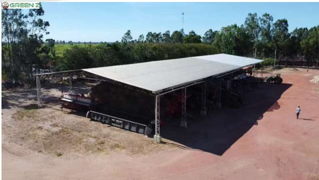
Figura 17. Galpão para acomodação de implementos agrícolas e de outros equipamentos comuns a rotina de atividades da fazenda Vereda da Lagoa. (Coordenadas Geográficas da posição de sobrevoo da referida área com drone: -07,5352 S; -43,3337 O. Data da imagem: 15/11/2023).
