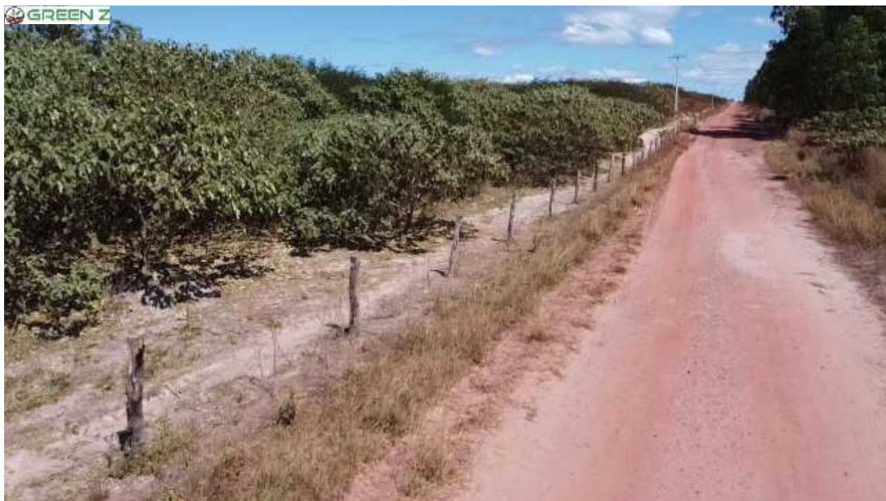
Figura 22. Representação da estrutura de uma estrada/aceiro com a finalidade de prevenção de incêndios e mobilidade interna. (Coordenadas Geográficas da posição de sobrevoo da referida área com drone: -07,5415 S; -43,3418 O. Data da imagem: 15/11/2023).
