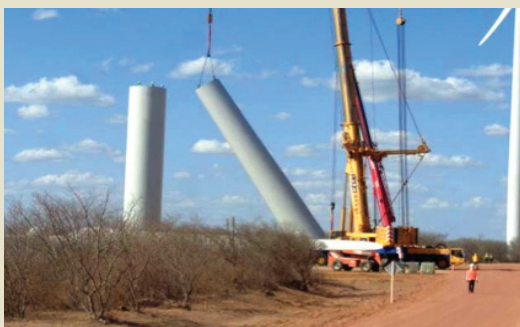
Montagem do segundo seguimento da torre
