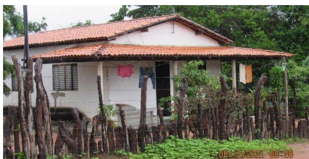
Figura 44. Imóvel com paredes revestidas com reboco total na área de abrangência da Fazenda Jerusa em Canavieira – PI.
