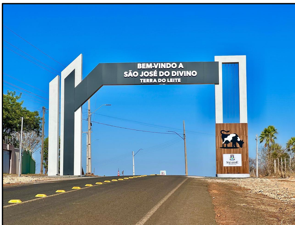
Figura 26. Pórtico de entrada da cidade.
