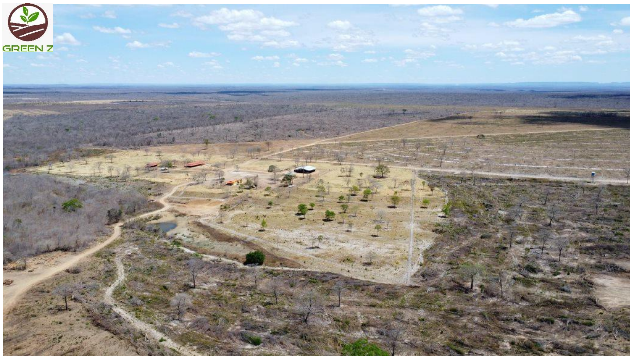
Figura 4. Visão geral Fazenda Santa Rita, evidenciando parte da área produtiva, infraestruturas construídas em área consolidada e vegetação nativa ao fundo (Coordenadas Geográficas da posição de sobrevoo da referida área com drone: -10,537753 S, -44,682205 O. Data da imagem: 23/08/2022).
