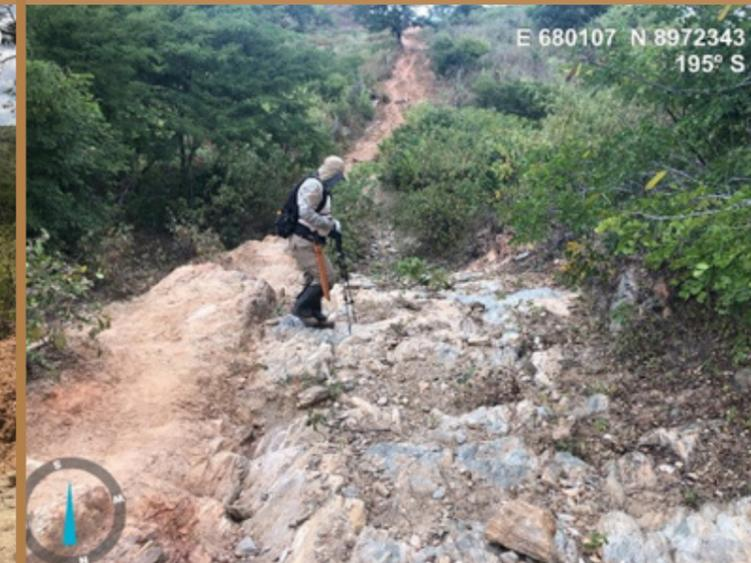
▲ Estrada abandonada no limite leste da área de estudo. A declividade acentuada e o fluxo de água pluvial turbulento provocaram o aparecimento de diversas feições erosivas no local, sobretudo sulcos e ravinas de diversas dimensões.
