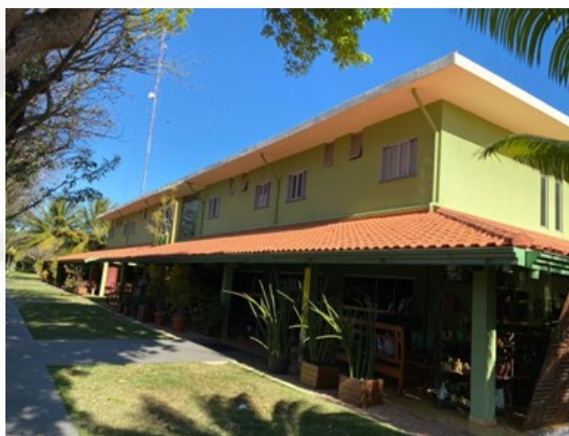
Foto 13– Alojamentos Sede Faz. Progresso (27/07/23)
