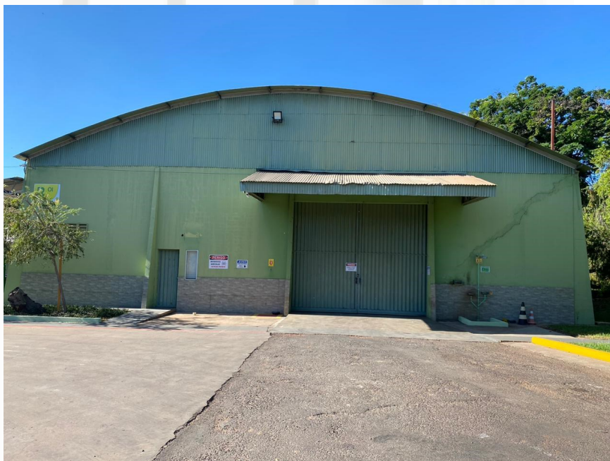
Foto 31 – Vista do galpão de armazenamento de produtos defensivos agrícolas e embalagens vazias, existente na sede da Fazenda Progresso.
