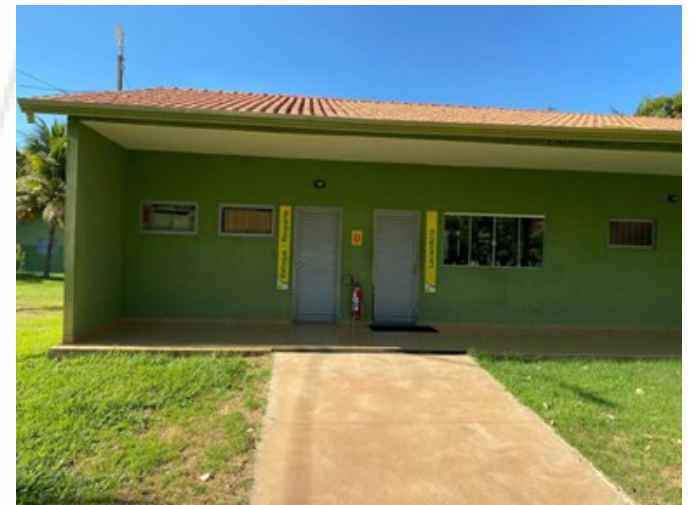
Foto 17 – Lavanderia Sede Faz. Progresso (27/07/23)
