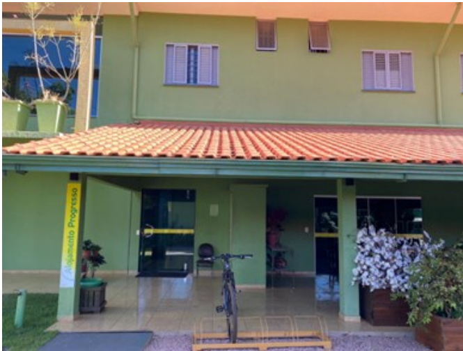
Foto 14 – Alojamentos Sede Faz. Progresso (27/07/23)
