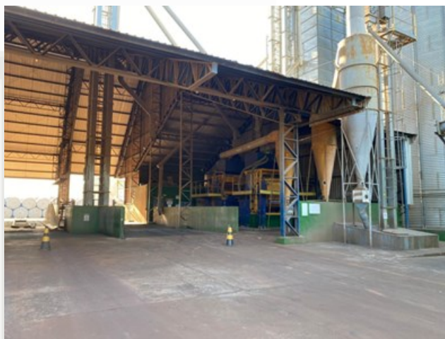
Foto 11– Silo pulmão Sede Faz. Progresso (27/07/23)
