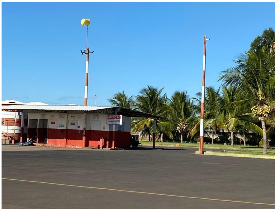
Foto 32 – Vista da estrutura do local destinado a preparação das caldas de defensivos utilizados nas atividades agrícolas, existente na sede da Fazenda Progresso.
