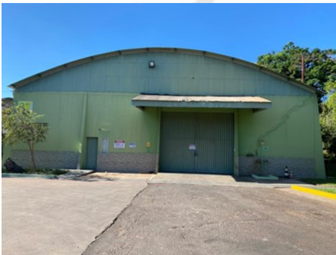
Foto 16 - Depósito de defensivos e embalagens vazias, Sede Faz. Progresso (27/07/23)
