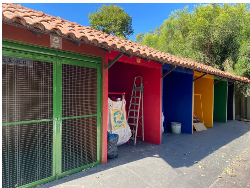
Foto 33 – Vista das baias de segregação dos resíduos recicláveis, existentes na sede da Fazenda Progresso.
