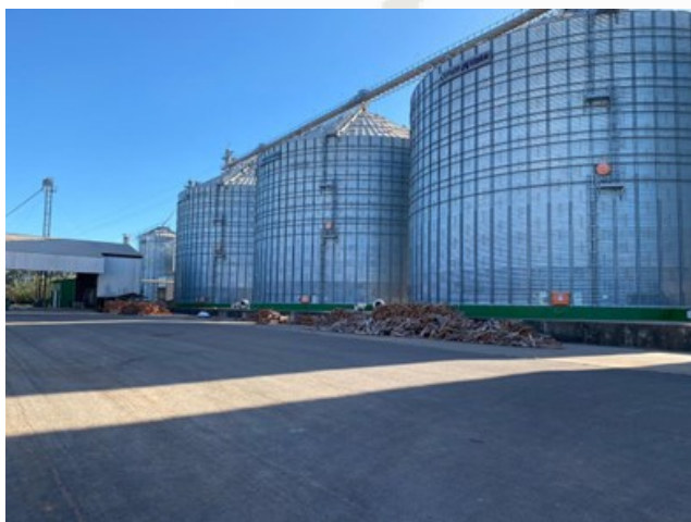
Foto 10– Silos Sede Faz. Progresso (27/07/23)
