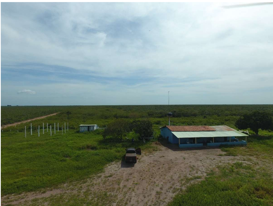
Sede dos imóveis Nossa Senhora das Graças 4 e 5 e area de apoio para instalação de infraestrutura do empreendimento
