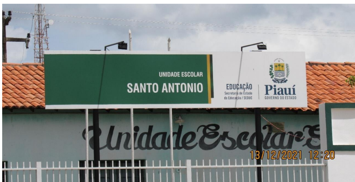
Figura 66. Unidade Escolar Santo Antonio no município de Flores do Piauí – PI.
