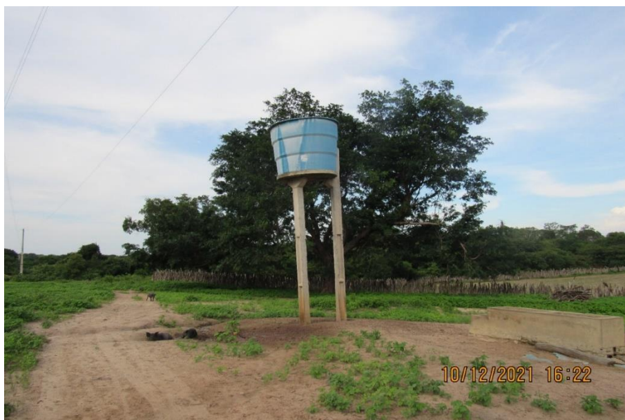
Figura 75. Reservatório de água que abastece o Povoado Riachinho na área de abrangência da Fazenda Maravilha em Flores do Piauí – PI.
