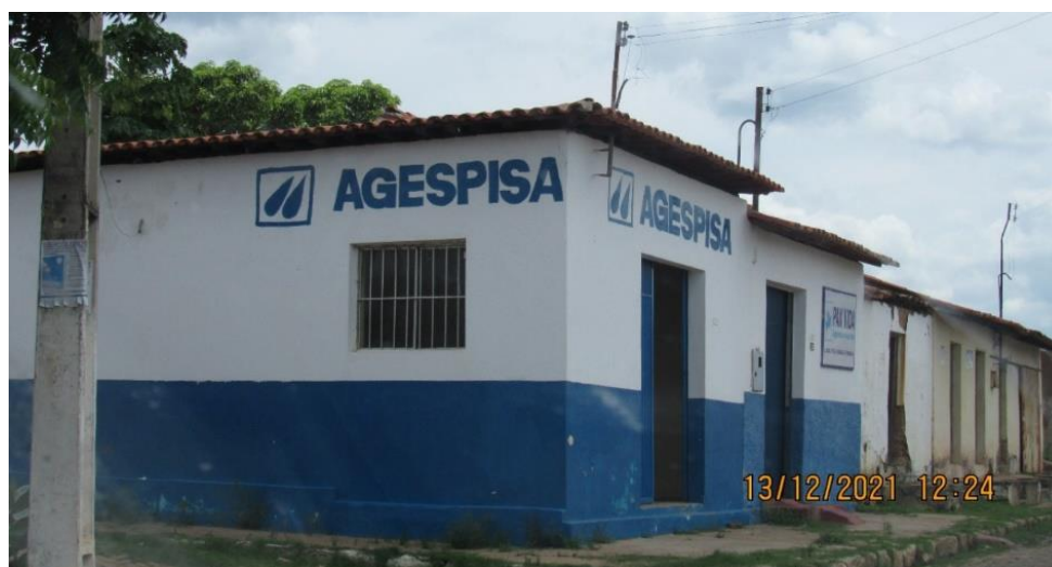
Figura 68. Águas e Esgotos do Piauí S/A - AGESPISA no município de Flores do Piauí - PI.
