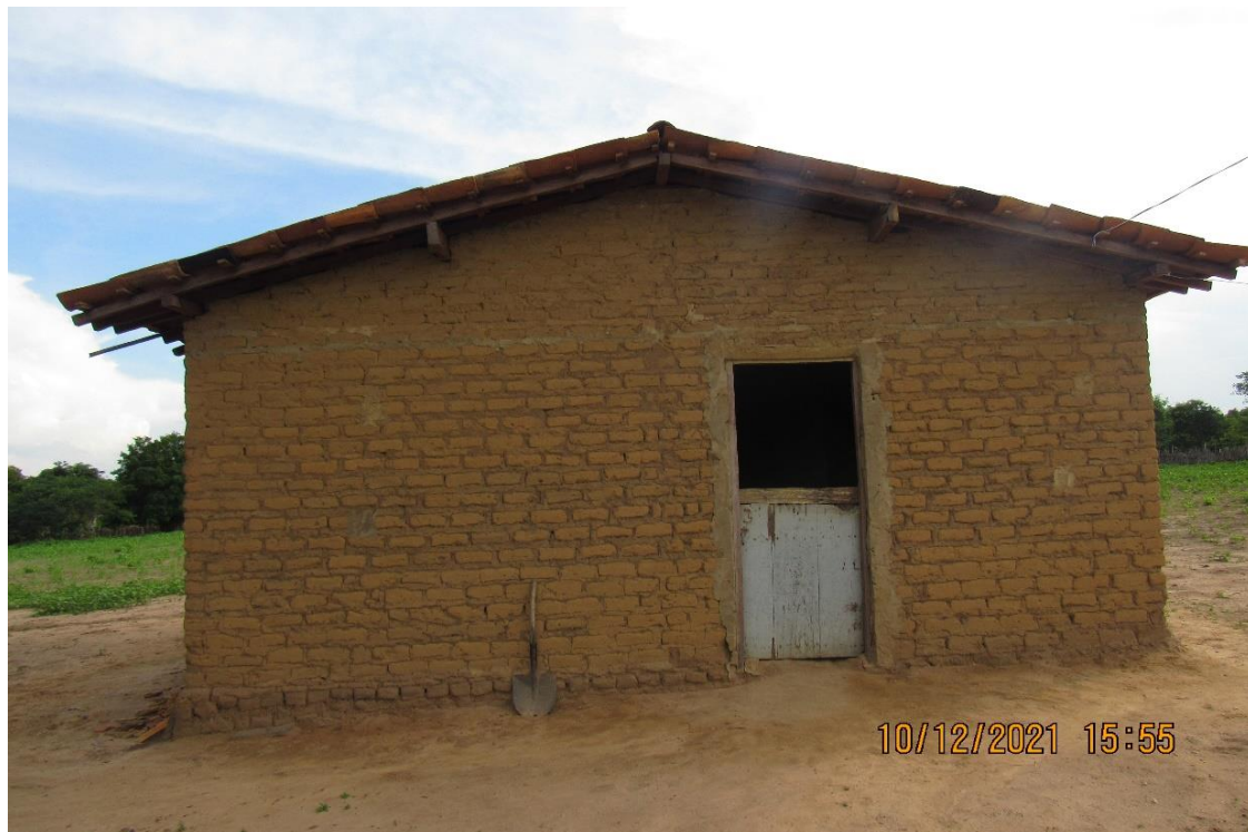
Figura 73. Moradia construída com adobe sem revestimento de cimento nas paredes e com piso de chão batido no Povoado Riachinho na área de abrangência da Fazenda Maravilha em Flores do Piauí – PI.
