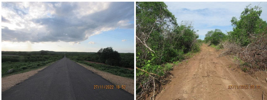
Figura 3. Acessos do empreendimento (rodovia PI-141 e estrada rural dentro da propriedade).
