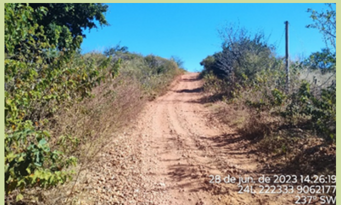
Estrada de acesso não pavimentada.
