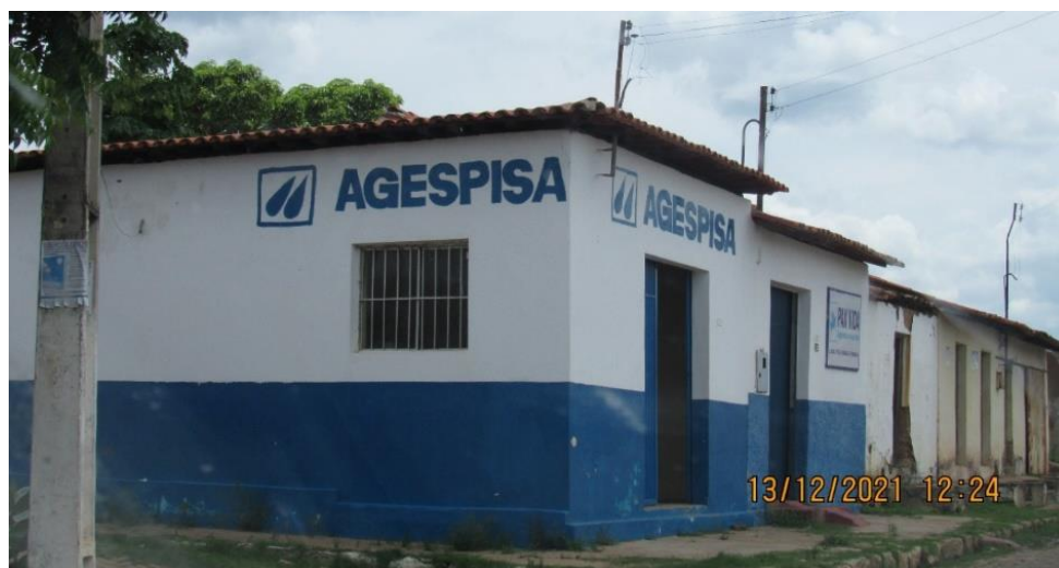
Figura 43. Águas e Esgotos do Piauí S/A - AGESPISA no município de Flores do Piauí - PI.
