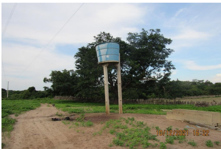
Figura 50. Reservatório de água que abastece o Povoado Riachinho na área de abrangência da Fazenda Maravilha em Flores do Piauí – PI.
