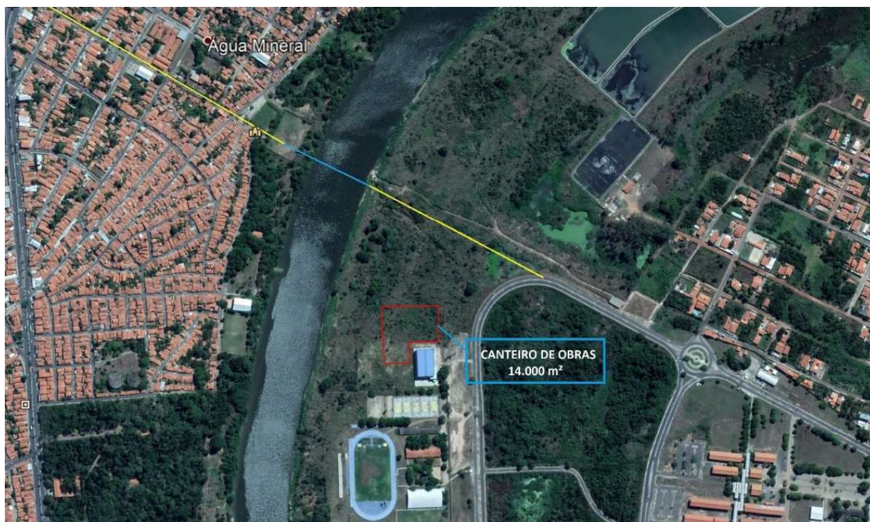
Figura 4. Localização das obras. (Fonte: PCA Engenharia 2018).
