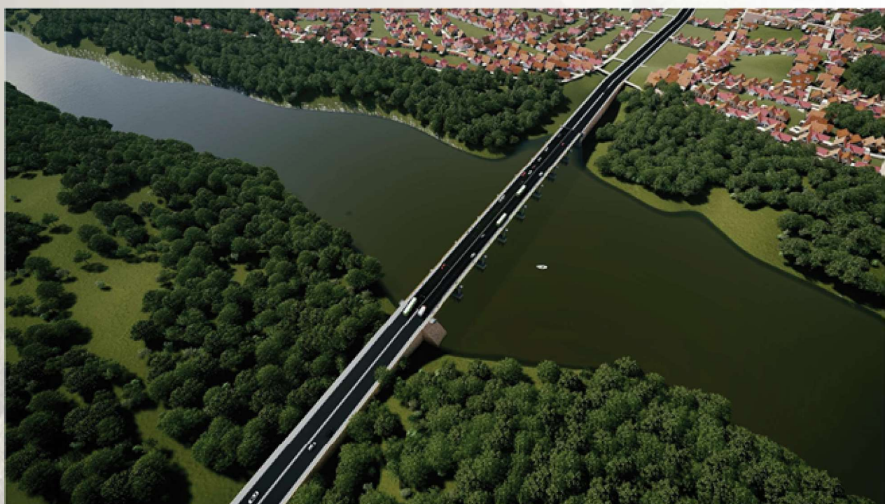
Figura 1: Ponte da Universidade. (Fonte: PCA Engenharia 2018).
