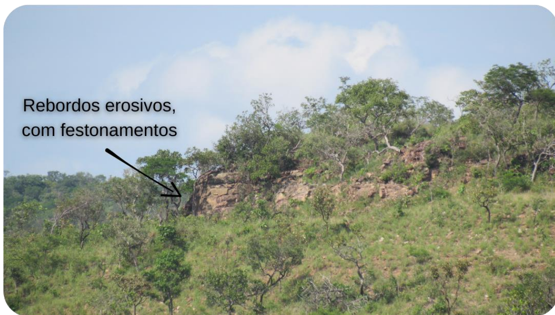
Figura 23. Rebordos erosivos com rocha exposta e marcas de festonamento.
