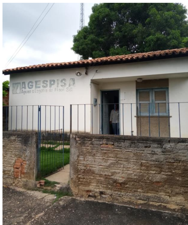
Figura 48. Escritório da Empresa Águas e Esgoto do Piauí S/A – AGESPISA.
