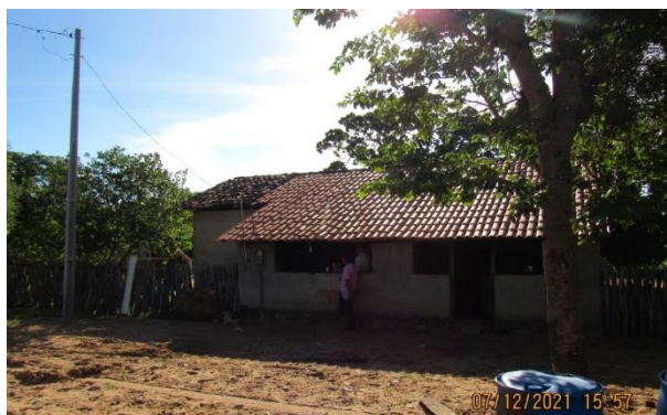
Figura 46. Imóvel com revestimento em reboco parcial na área de abrangência da Fazenda Jerusa em Canavieira – PI.
