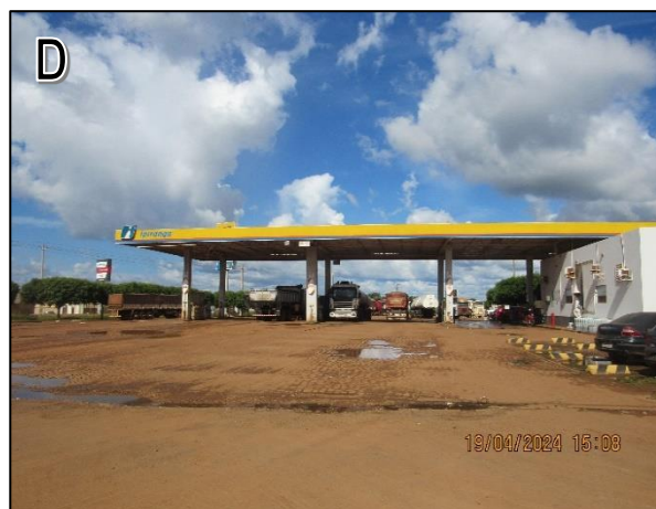
Trecho da via de acesso ao bairro Portal dos Cerrados
