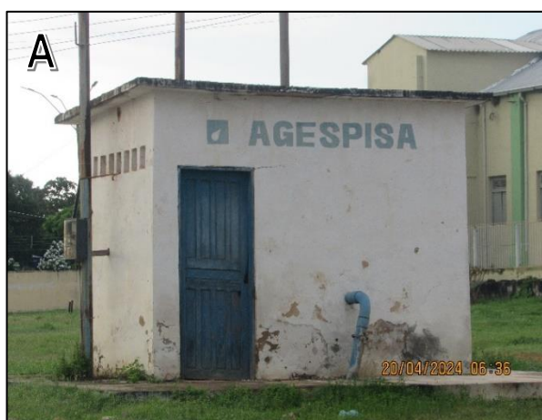
Casa das bombas d'água da AGESPISA
