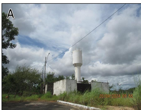
Reservatório de água no bairro Vista Bela
