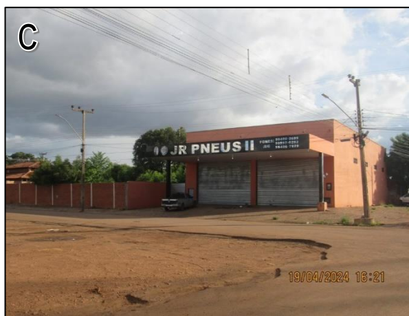
Trecho da PI-247, bairro Portal dos Cerrados
