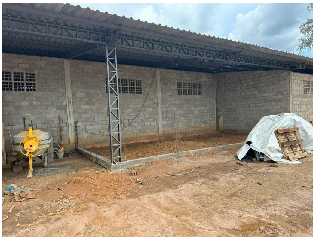
Galpão de defensivos e em construção área para armazenamento das embalagens vazias.
