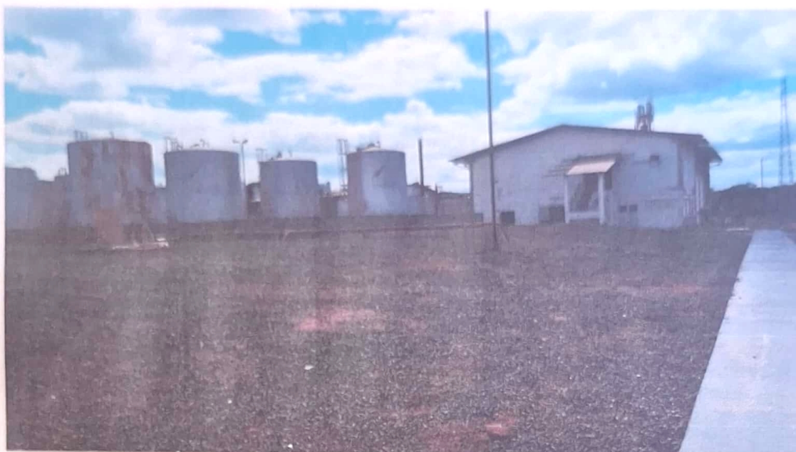
Fotografia 3. TANQUES E GALPÃO - UNIBRAS-FLORIANO
