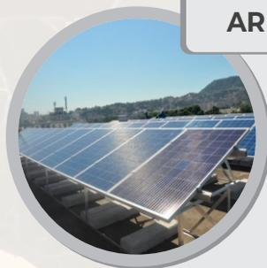
O arranjo fotovoltaico é a estrutura de combinação dos elementos geradores (módulos fotovoltaicos), conectados em série e em paralelo, a montante do inversor. O arranjo fotovoltaico típico do empreendimento é composto por: 171 strings fotovoltaicas. Cada string é composta por 26 painéis de 650 W em série
