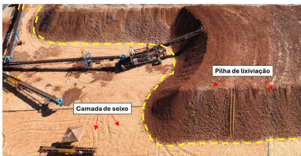
Figura 12: Ilustração do uso do seixo peneirado instalado na base do pátio de lixiviação do Projeto Piauí Níquel (fase PNP1000 em operação), que recebe as pilhas de minério de níquel britado para o processo de lixiviação.
