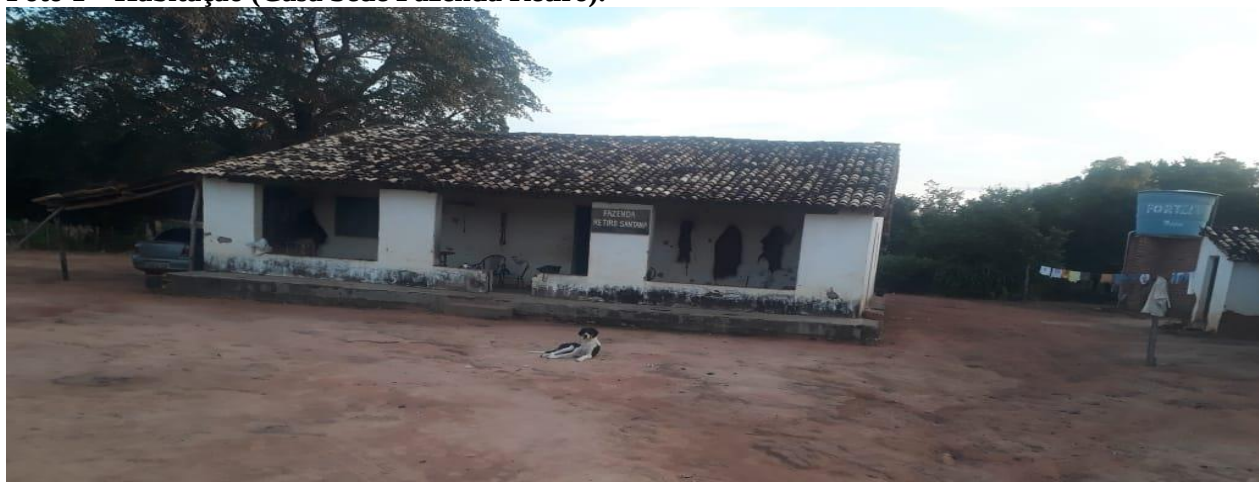
Foto 1 – Habitação (Casa Sede Fazenda Retiro).
