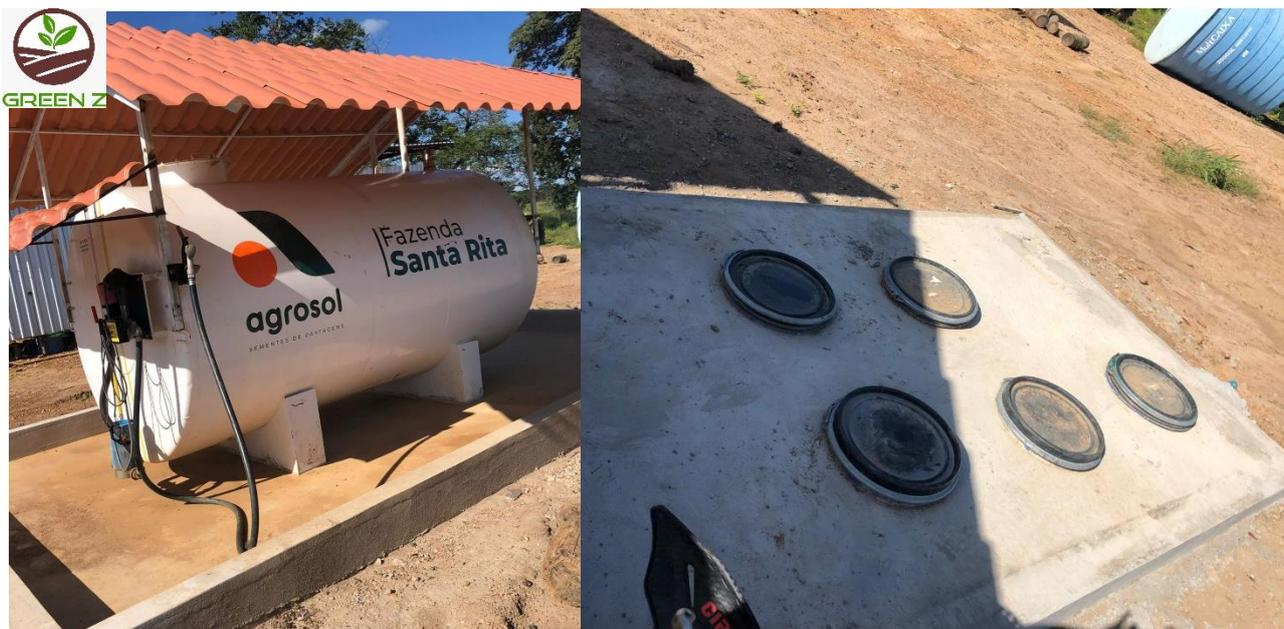
**Figura 12.** Tanque de combustível de 10.000 L de capacidade na Fazenda Santa Rita, com estrutura no entorno, conforme projetado pelo fabricante, com piso impermeável (impermeabilizante) e bacia de contenção **(FOTOS ATUALIZADAS)**.
