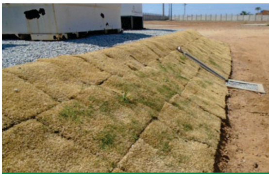
Exemplo de medida do PRAD: plantio de gramínea e implantação de drenagem pluvial no talude
