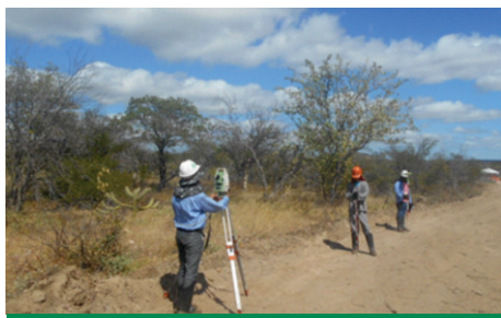
Exemplo de medida de controle de supressão – equipe de topografia demarcando o perímetro das áreas a serem suprimidas
